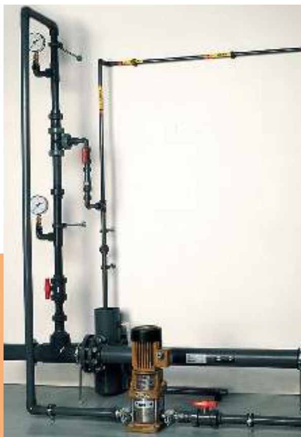
Ozon-Wasser-Vermischungseinrichtung
