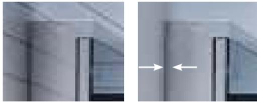
Das integrierte U-Profil berücksichtigt einen Wandausgleich von 18 mm. Das erweist sich bei nicht ganz geraden Wänden, wie das z.B. im Altbau häufiger der Fall ist, als Vorteil.
