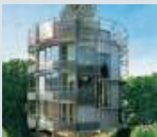
Heliotrop Freiburg, Deutschland
