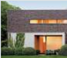
Einfamilienhaus Kevelaer, Deutschland
