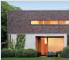
Einfamilienhaus Kevelaer, Deutschland
