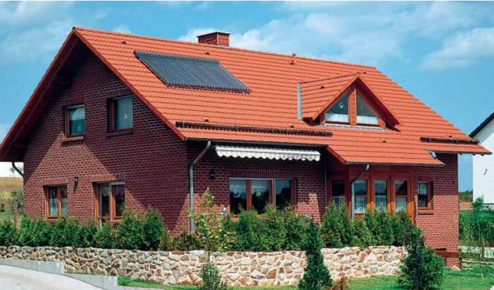
Röhrenkollektoren können lageunabhängig montiert werden.
