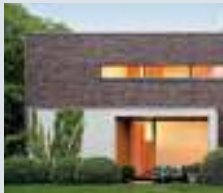
Einfamilienhaus Kevelaer, Deutschland
