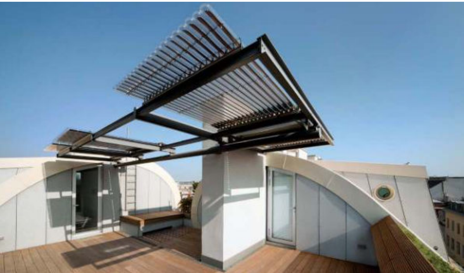
Röhrenkollektoren Vitosol 300-T/200-T
